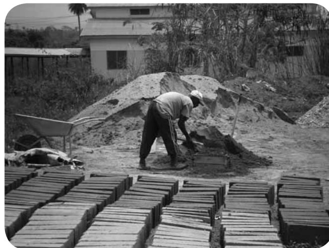
De stenen worden ter plaatse gemaakt en in de zon te drogen gelegd.
