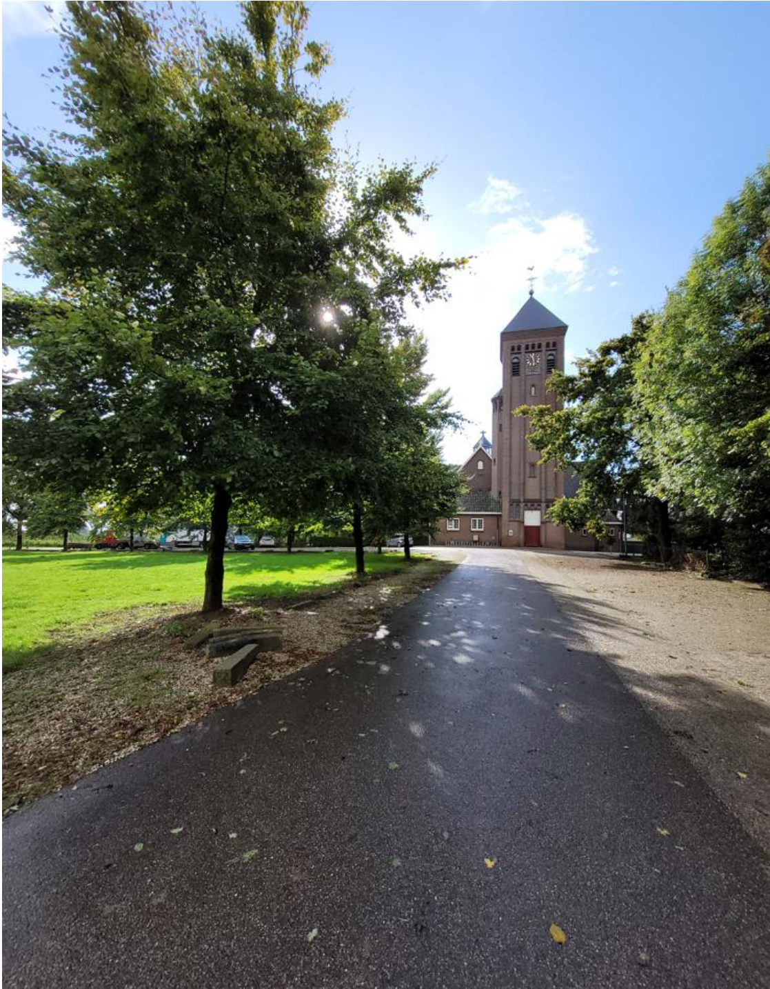
Foto 1: Entrée noordelijk, parkeerplaatsen
