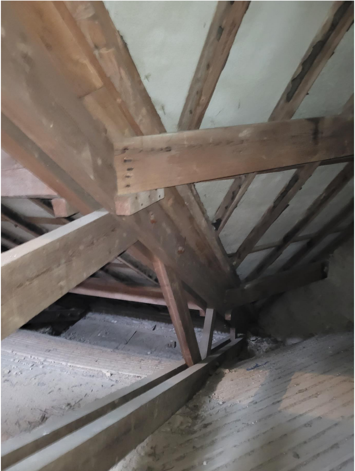
Foto 19: Kapconstructie: Gordingen en spanten
