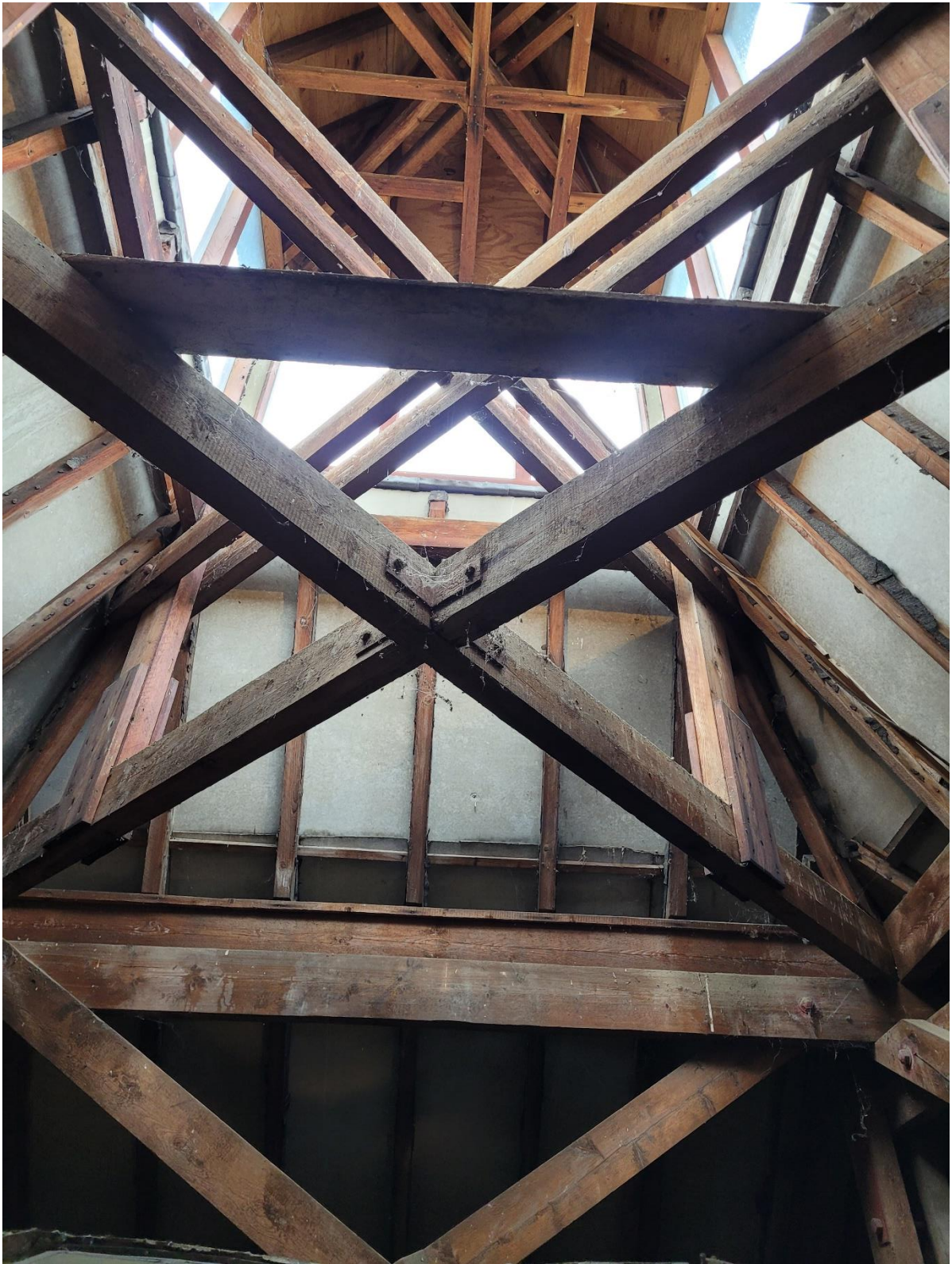
Foto 21: Kapconstructie: koepeltoren
