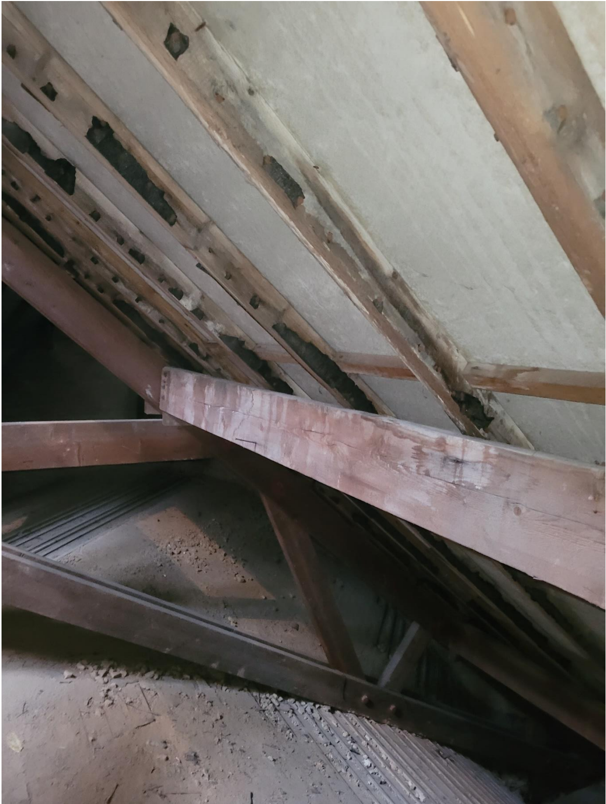
Foto 18: Kapconstructie: Gordingen en spanten
