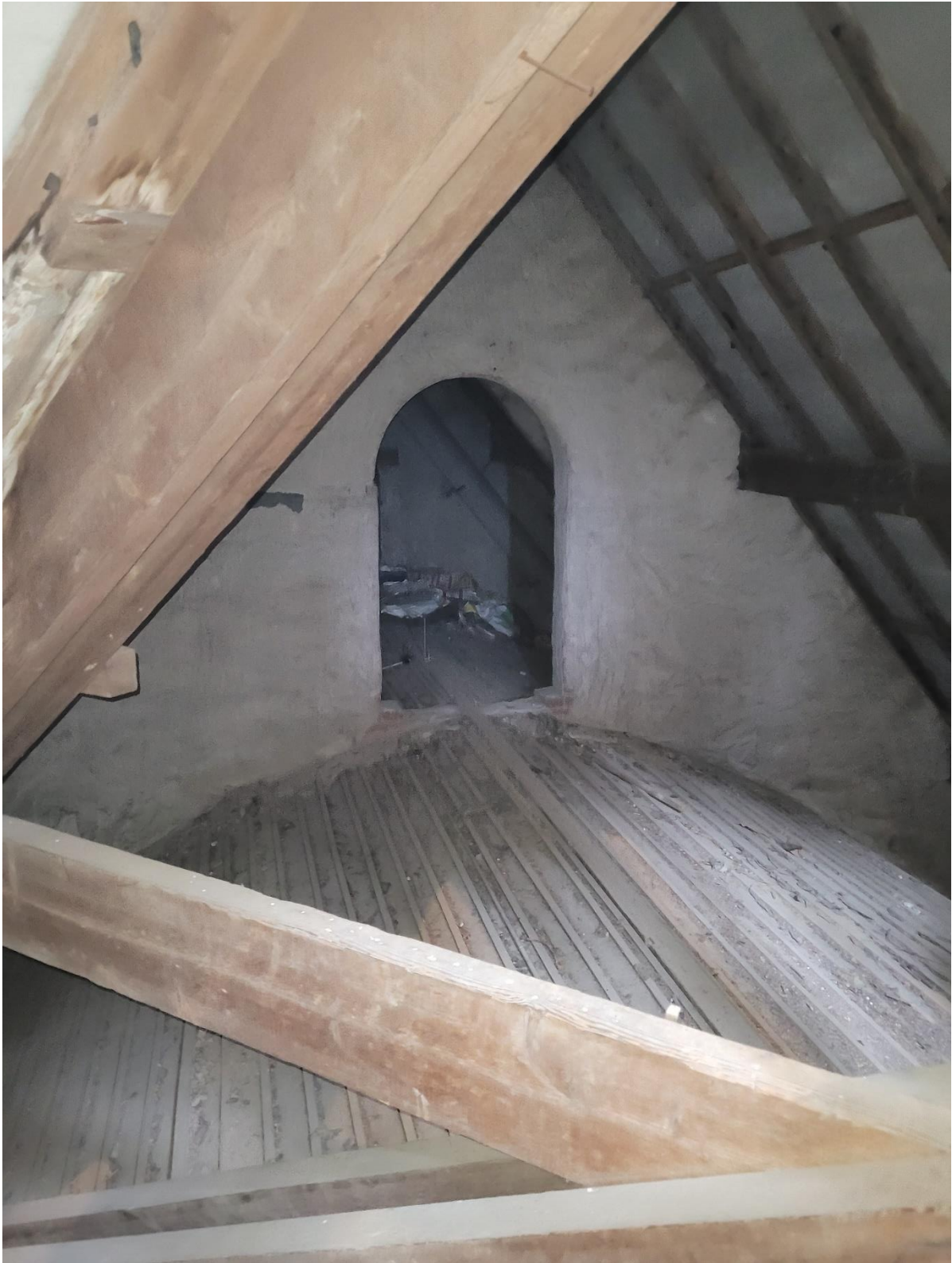
Foto 17: Kapconstructie – afwerking overwelling vieringsruimte
